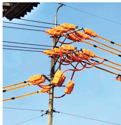
전선용방호관과 건축용방호구가 제대로 설치된 공사현장.
