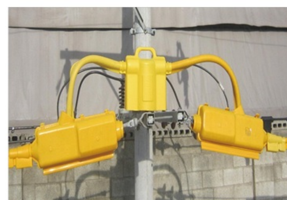
현장 설치도 - 점퍼선 개소 설치 사진 (모든 곡선개소 방호 가능)
